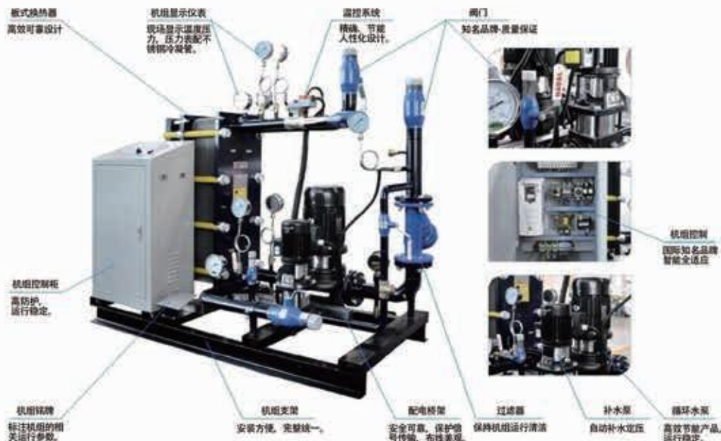
图 4-1 换热机组结构图
